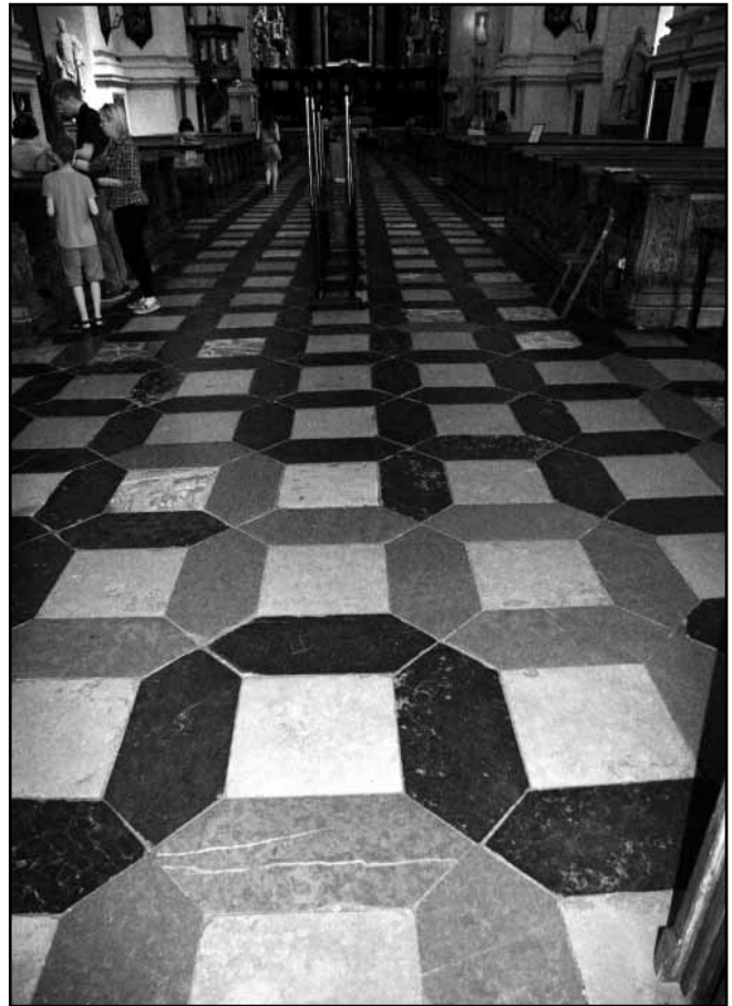
Рис. 10. Підлога центральної нави костелу св. Петра і Павла 1619 р. у Кракові, скомбінована з мармурових шестикутних та квадратних плит. Тут і далі фото В. Мезенцева, 2014–2015 рр.
