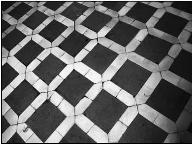
Рис. 20. Підлога залу палацо Пітті 1458 р. у Флоренції, скомбінована з теракотових квадратних плит і половинок мармурових шестикутних вузьких плиток
