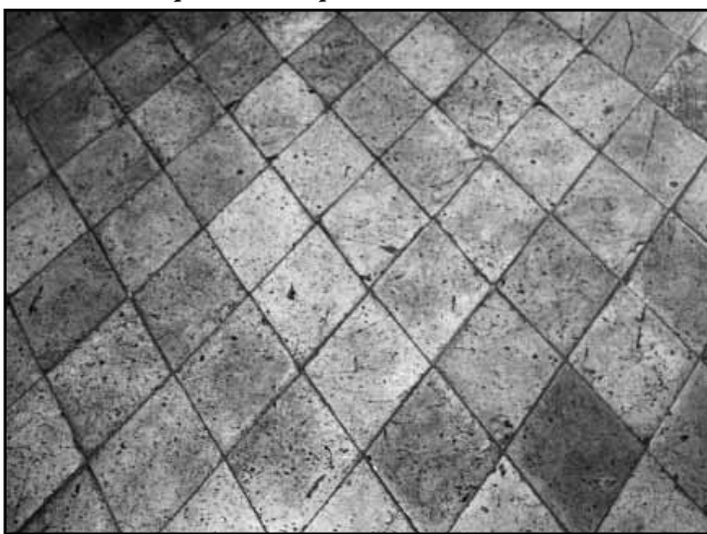
Рис. 17. Підлога кімнати палаццо Даванцаті, заможена квадратними теракотовими плитками
