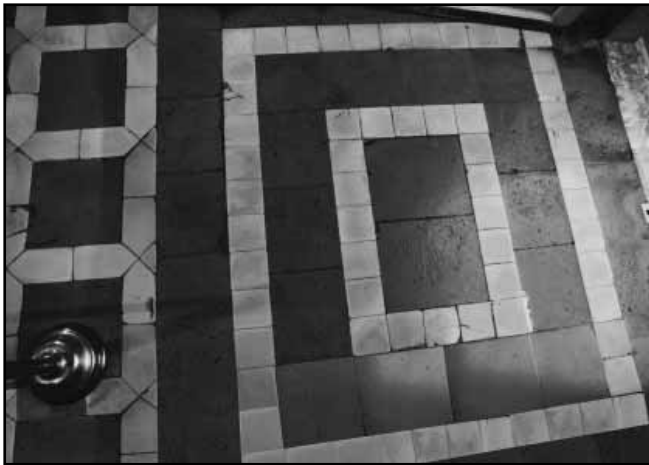
Рис. 21. Орнамент підлоги кімнати палацо Пітті з концентричних прямокутників, викладений малими квадратними мармуровими плитками та квадратними й прямокутними теракотовими плитами
