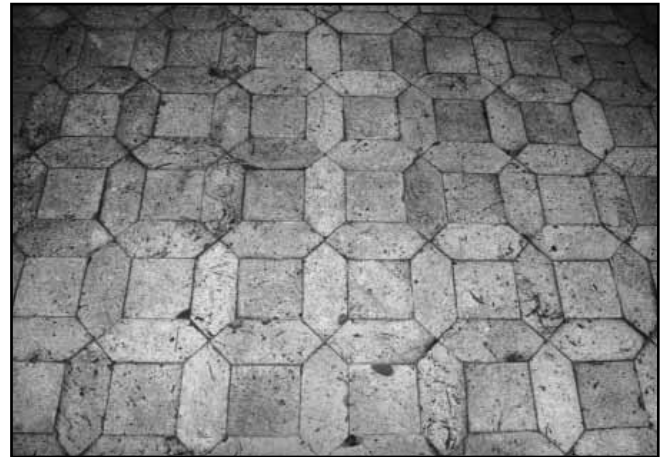
Рис. 15. Пізньоренесансна підлога зала палаццо Даванцаті у Флоренції, скомбінована з теракотових шестикутних і квадратних плиток
