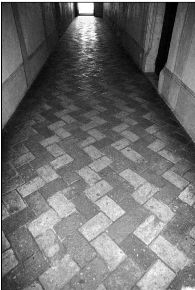
Рис. 9. Підлога коридору колегіуму 1400 р. Ягеллонського університету в Кракові, викладена теракотовими прямокутними плитками методом «у ялинку»
