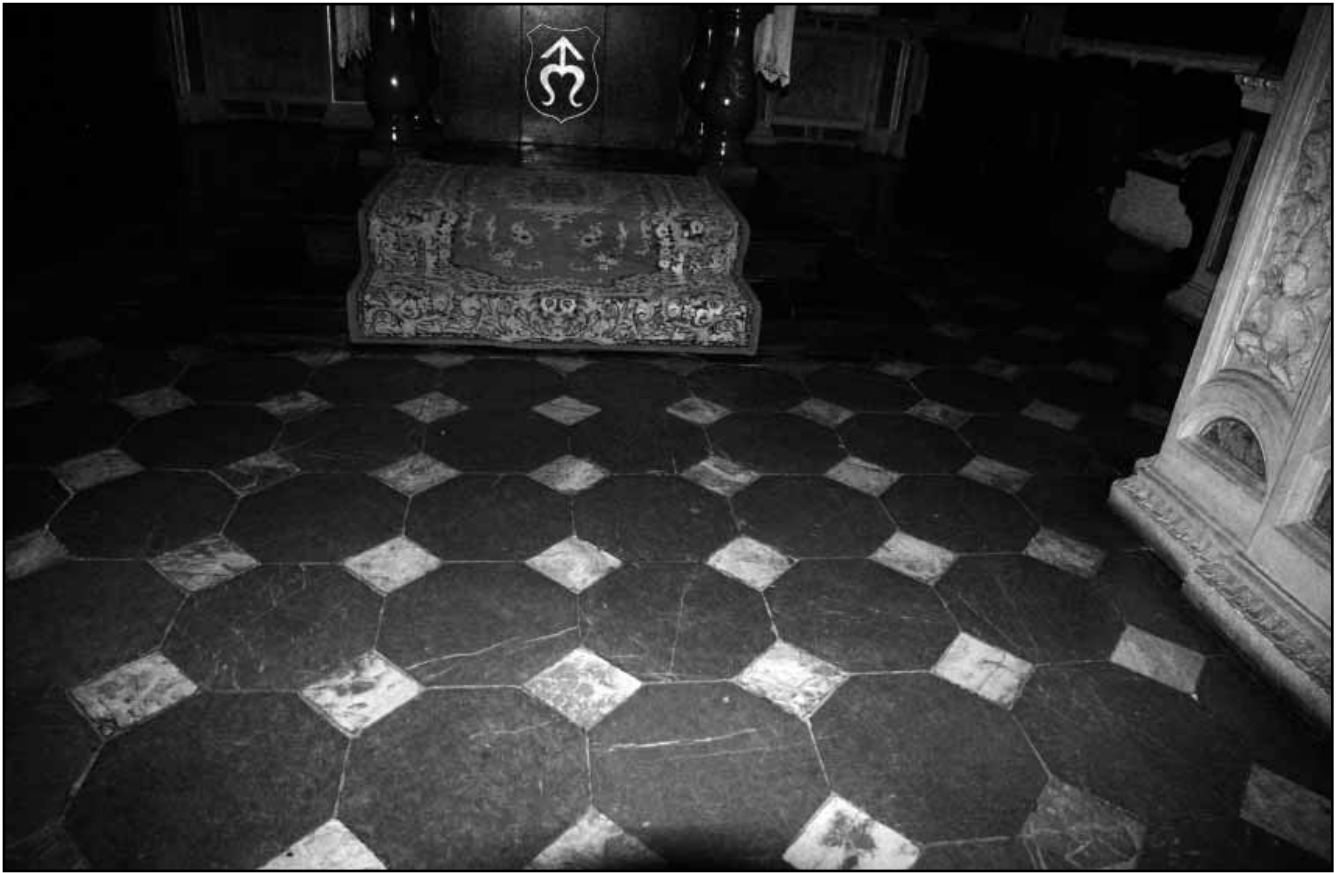
Рис. 11. Підлога бічної нави костелу св. Петра і Павла, викладена двоколірними мармуровими октагональними та малими квадратними плитками
