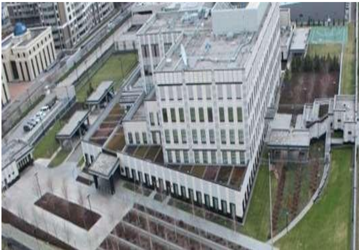
Рис. 1.2. Нова будівля посольства США (оцінка LEED Silver)
