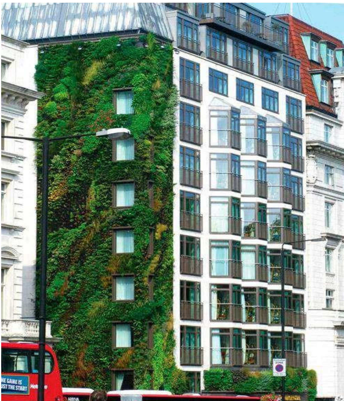
Рис. 2.13. Проект П. Бланка: вертикальне озеленіння частини фасаду отеля поблизу від Гайд-Парку, Лондон (Великобританія)
