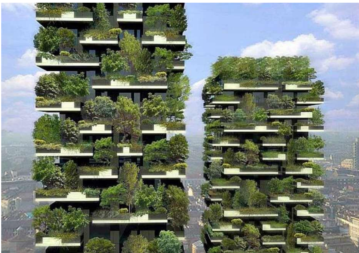
Рис. 2.8. Модульне або комбінаторне озеленіння фасаду
