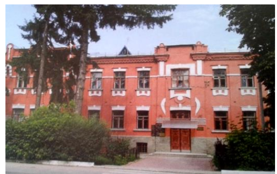
Центральний корпус ЗОШ І-ІІІ ст. №4
