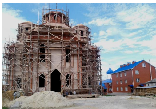
Будівництво храму Барської ікони Богородиці на території скиту Браїлівського жіночого монастиря
