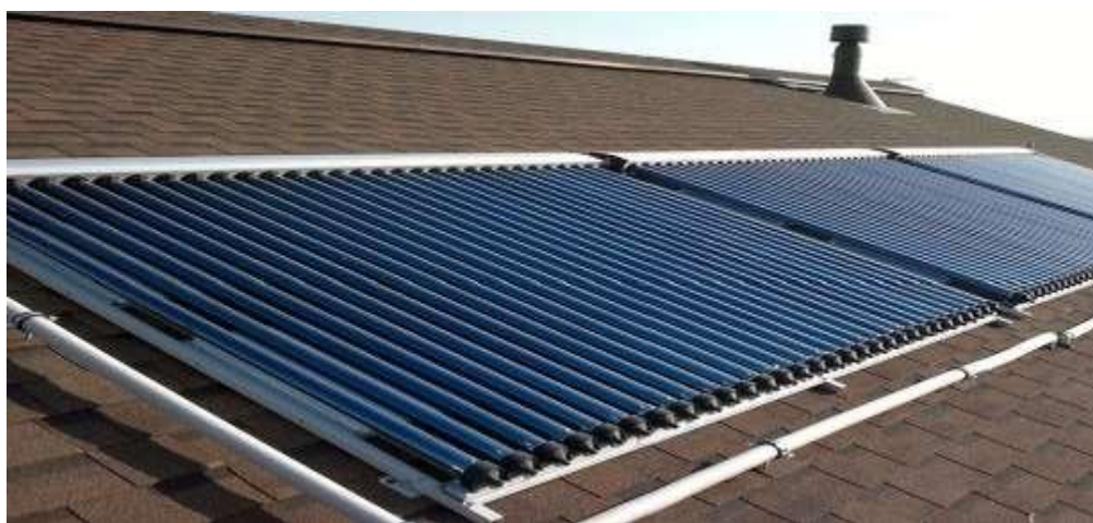
Рис.1.6 Вакуумний сонячний колектор
