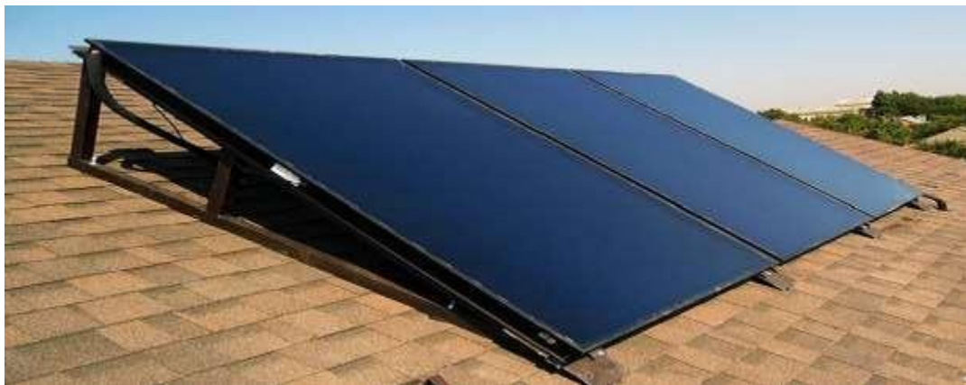
Рис.1.5 Плоский сонячний колектор
