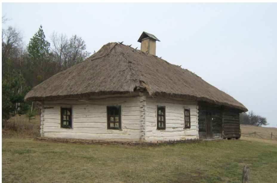
Рублена хата з села Бзів. Зруб чітко показаний і в площині стіни та у кутових з'єднаннях. Між житловим приміщенням і приміщенням для дрібної худоби розташовано сіни. Стіни холодних підсобних приміщень залишаються в дереві.
