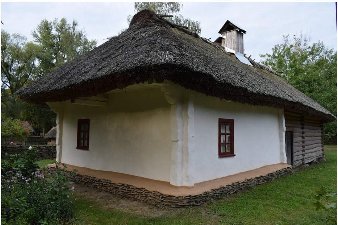
Великий звис даху на бічному фасаді (на кронштейнах). Хата із с.В'юнище Переяслав-Хмельницького району Київської області, Переяслав-Хмельницький
