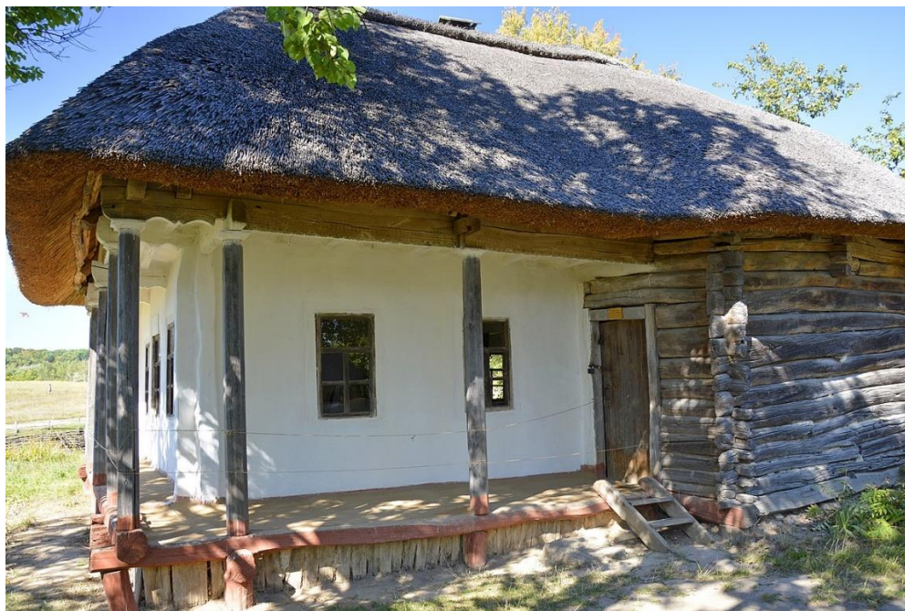
Звис даху підтримується колонами.
