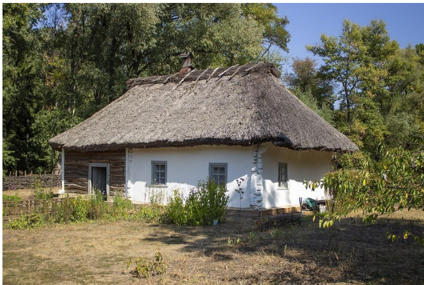
Рублена хата. Зруб чітко видно в кутових з'єднаннях. Стіна житлового приміщення вкрита шаром обмазки
